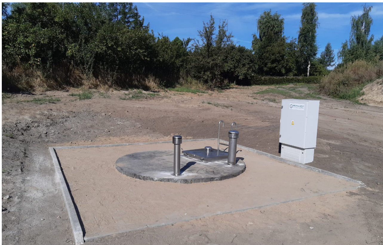
Fot. 6 Budowa przepompowni ścieków w miejscowości Płużnica
