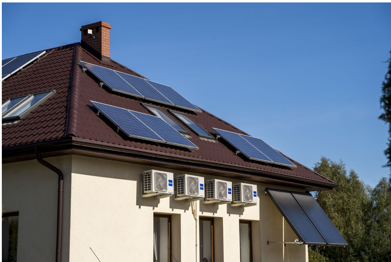
Fot. 12 Zakup i montaż klimatyzacji w budynku GOPS
