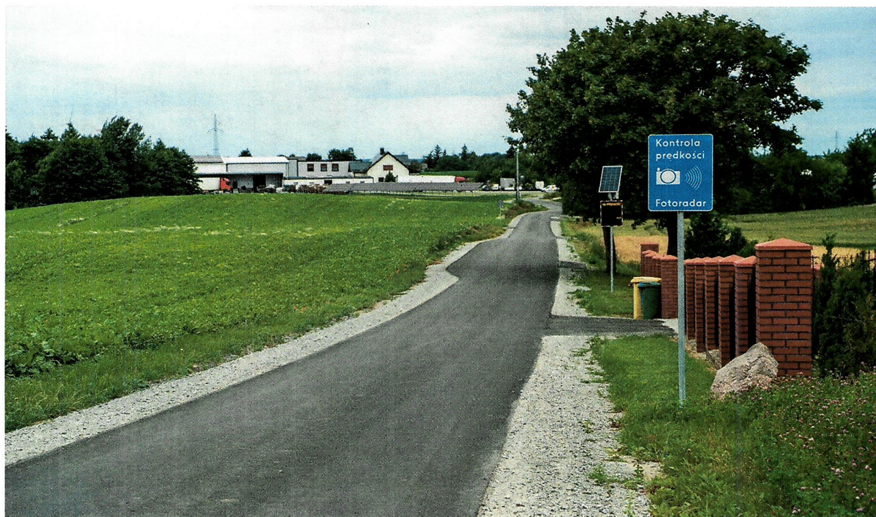
Fot. 4 Przebudowa drogi gminnej w Płachawach – 904 tys. zł
