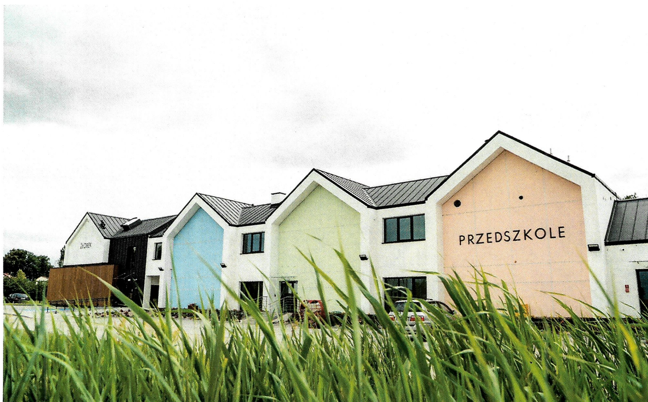
Fot. 5 Dokończenie budowy przedszkola w Płużnicy – 818 tys. zł
